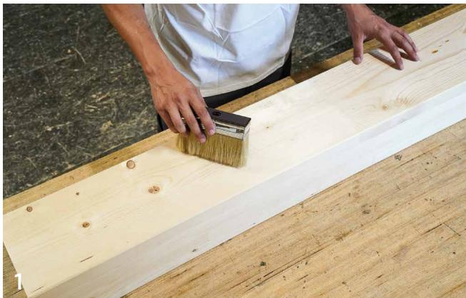
Avant le collage, nettoyer soigneusement la surface, qui doit être lisse, uniforme et sans irrégularités. Tout éventuel dommage sur la surface doit être évalué et traité de manière appropriée avant la pose de la membrane.
